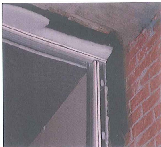
Tradosado y techo aislante con LA.
